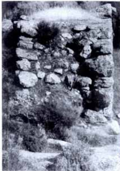
Τομή στο μέτωπο του τείχους με το υλικό πλήρωσης (κατά J. Knauss, 1966)
