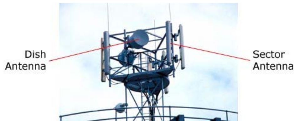
Εικόνα 19. Τα κύρια μέρη ενός σταθμού βάσης
