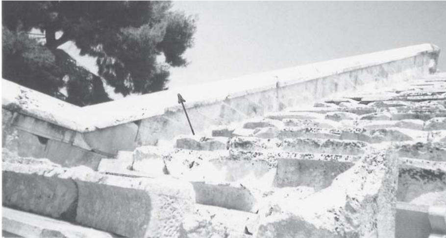
Φωτ. 4. Η κουπασή του Αρχαίου Θεάτρου είναι επίσης κατασκευασμένη από υλικό των ίδιων ασβεστόλιθων.
