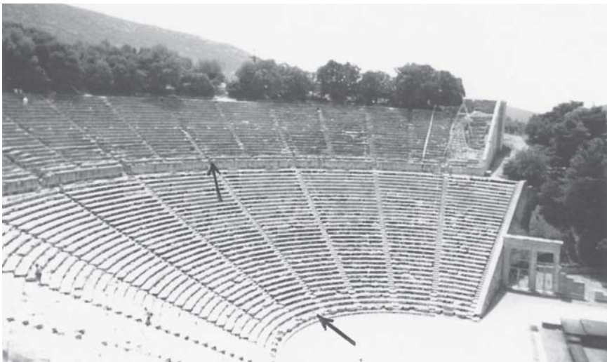
Φωτ. 3. Άποψη του Αρχαίου Θεάτρου με τις δύο σειρές θέσεων που κατασκευάστηκαν με υλικό από τους οριζόντες των ερυθρών ασβεστόλιθων φάσης “Hallstatt”.
