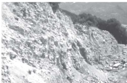
Σχ. 5. Καταστροφή γεωτόπου Ammonitico Rosso λόγω λατόμευσης για τη χρήση του ως δομικού υλικού (θέση Σκάνδαλο)
