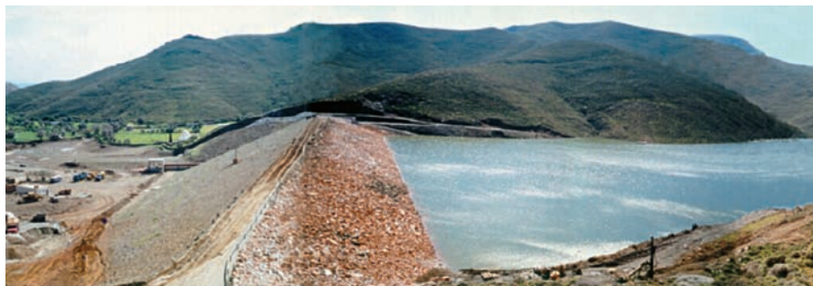
Εικόνα 2. Φράγμα Λειβαδιού νήσου Αστυπάλαιας.
