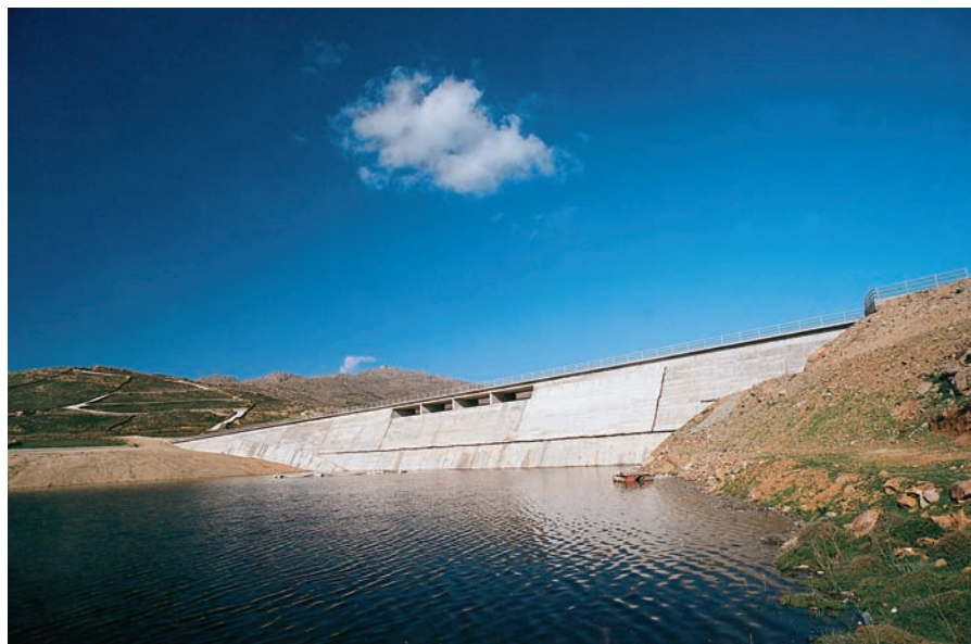
Εικόνα 3. Φράγμα Μαραθιά νήσου Μυκόνου.
