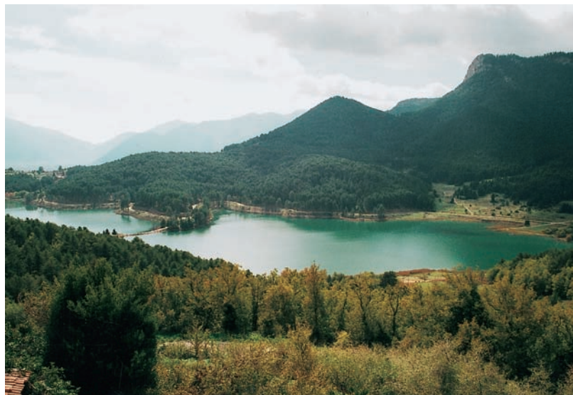
Εικόνα 5. Φράγμα Δόξα Φενεού νομού Κορινθίας.
