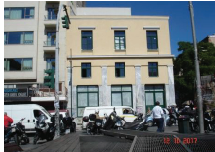
10. Οκτώβριος 2017. Το κτίριο της συμβολής των οδών Ερμού και Αθηνάς στο στάδιο της τελικής ανακαίνισης. Φωτογραφία: Κ. Γκόρτσος.
