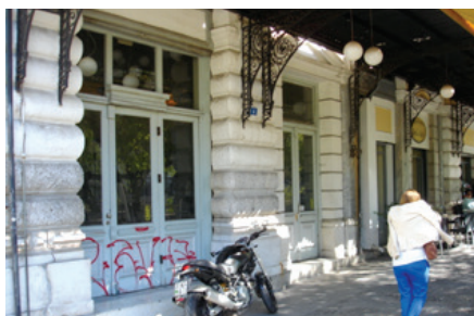
14. Οκτώβριος 2017. Ανατολικά της οδού Αθηνάς. Δρόμοι που περικλείουν την πλατεία. Οδός Ευπόλιδος. Φωτογραφία: Κ. Γκόρτσος.
