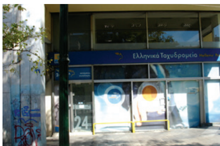
13. Οκτώβριος 2017. Ανατολικά της οδού Αθηνάς. Δρόμοι που περικλείουν την πλατεία. Οδός Ευπόλιδος. Φωτογραφία: Κ. Γκόρτσος.
