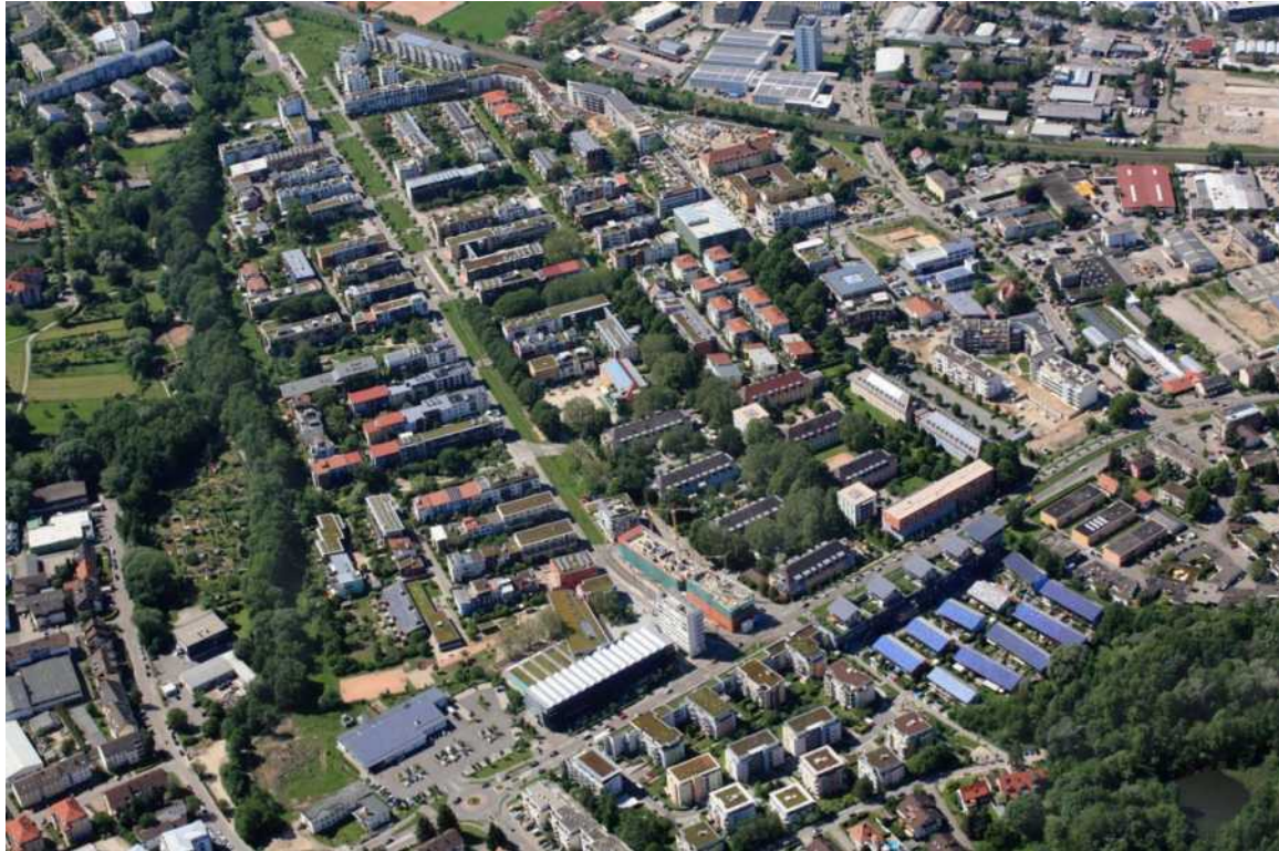
Εικόνα 10. Η γειτονιά Βάουμπαν κατά την ολοκλήρωση των έργων ανάπλασης (2012)
